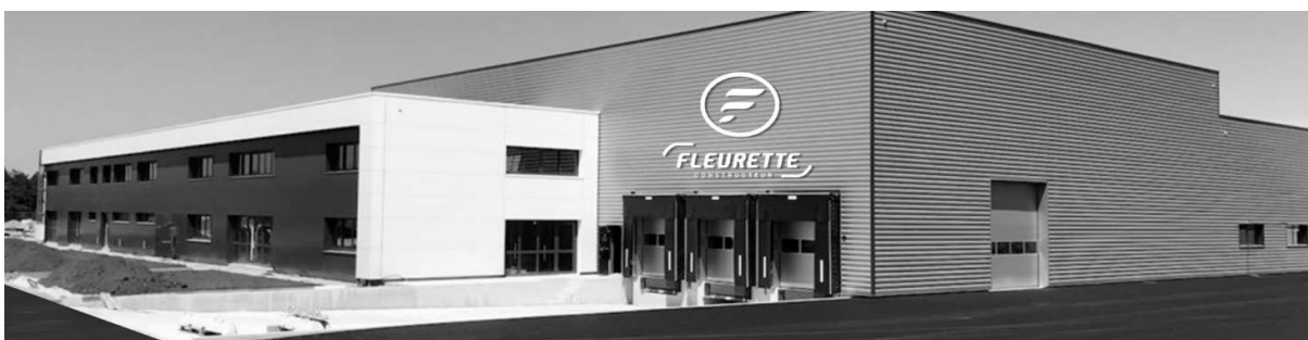
Visite de l'usine de Fleurette
